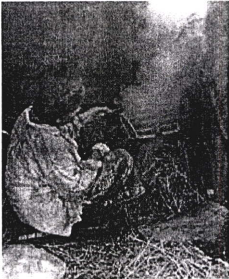
ภาพที่ 2.3 วิธีการรมควันในแบบดั้งเดิม เป็นวิธีการที่ผู้รมควันต้องเข้าไปรมควันในห้องด้วยเพื่อคอยสังเกตสีและความสม่ำเสมอของผลิตภัณฑ์เครื่องจักสานซึ่งเป็นอันตรายอย่างมาก
