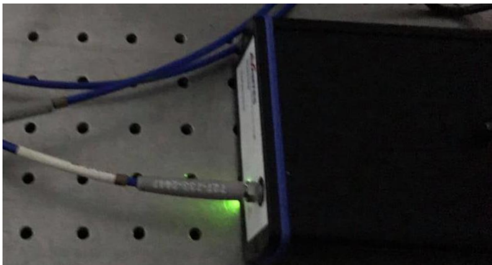
รูปที่ ข.6 แสดงการต่อสายไฟเบอร์
