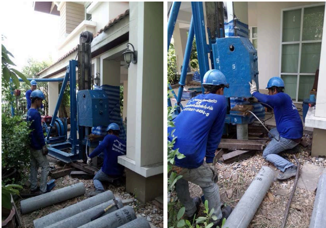
รูปที่ 2.15 การเสริมเสาเข็ม สปันไมโครไพล์ ด้วยชุดปั้นจั่น
