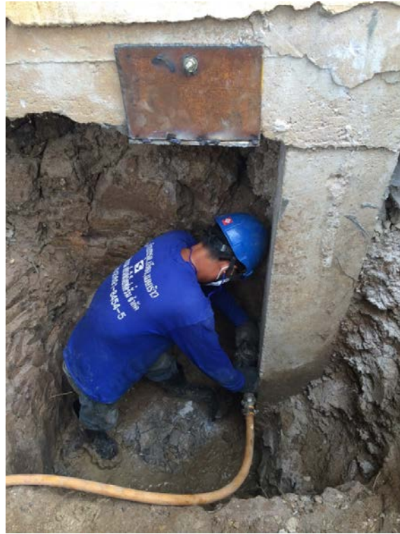
รูปที่ 2.12 เตรียมหน้างานก่อนการกดเสาเข็ม สปันไมโครไพล์ ด้วยชุดแม่แรง ไฮดรอลิก
