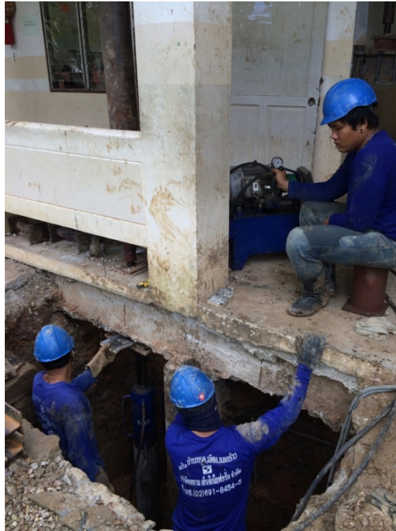
รูปที่ 2.13 กตเสาะเข็ม สปันไมโครไพล์ ด้วยชุดแม่แรง ไฮดรอลิก
