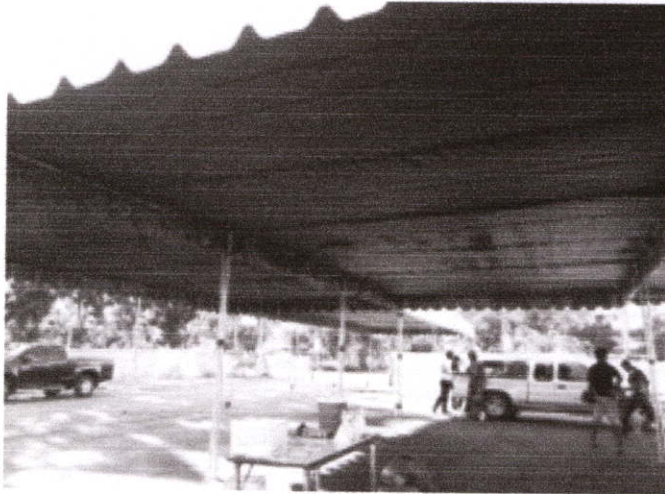
รูปที่ 2.58 : การติดตั้งแผ่นสแลมเพื่อกักอากาศให้เป็นฉนวนความร้อน
