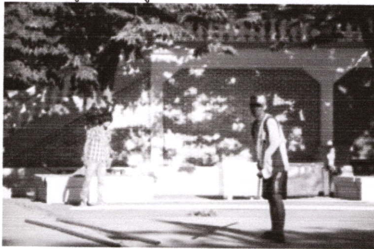
รูปที่ 2.37 : โดยนำเสามาวางไว้ตรงจุดที่จะติดตั้ง
