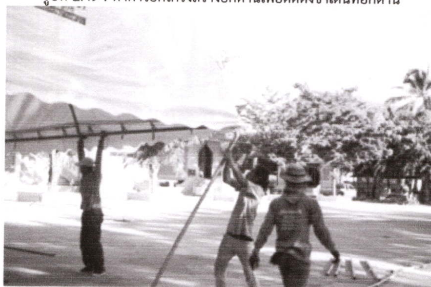
รูปที่ 2.50 : ติดตั้งขาตั้งที่ด้านที่เหลือ
