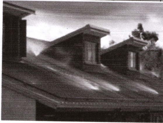
รูปที่ 2.64 : ทำความเย็นใช้น้ำคลายความร้อนจากวัสดุ
