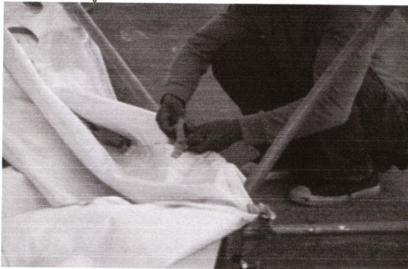
รูปที่ 2.44 : นำผ้าใบผูกติดกับโครงหลัก
