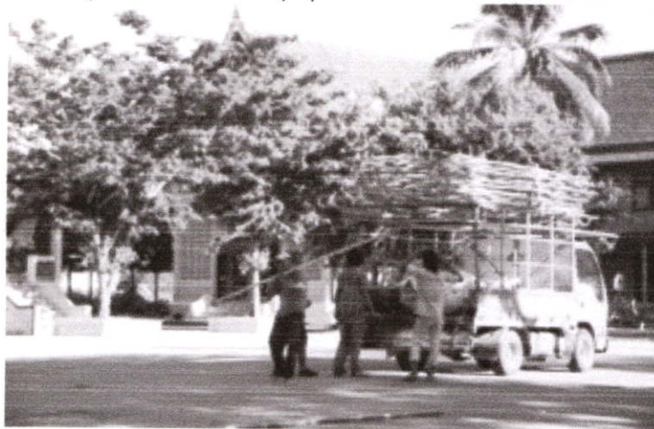
รูปที่ 2.35 : ผู้ติดตั้งทยอยขนอุปกรณ์ลงจากรถ
