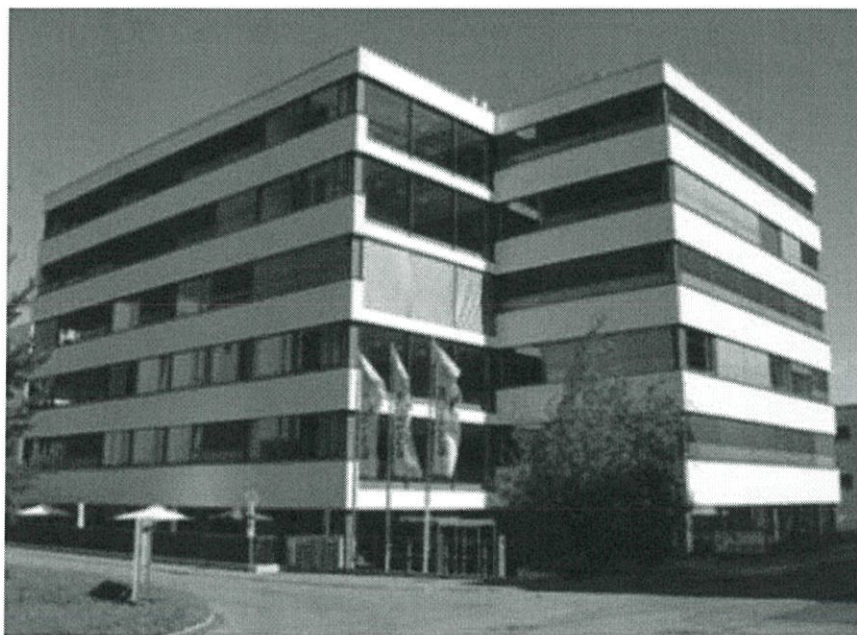
ภาพที่ 2. 1 อาคารสำหรับการทดลองระบบควบคุมอาคารอัตโนมัติ ที่ Switzerland
