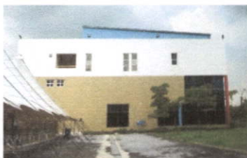
รูปภาพที่ 1.3 รูปอาคารทางทิศเหนือ
