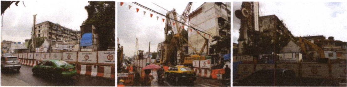
รูปที่3-13 ขณะทำการก่อสร้างรถไฟฟ้าใต้ดินปัจจุบัน
