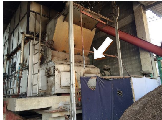
รูปที่ 4.20 (ง) ผนังด้านข้าง (ฝั่งติดผนังอาคาร)
