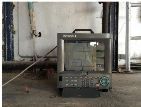
รูปที่ 4.21 เครื่องบันทึกอุณหภูมิที่ใช้ในการตรวจวัด
