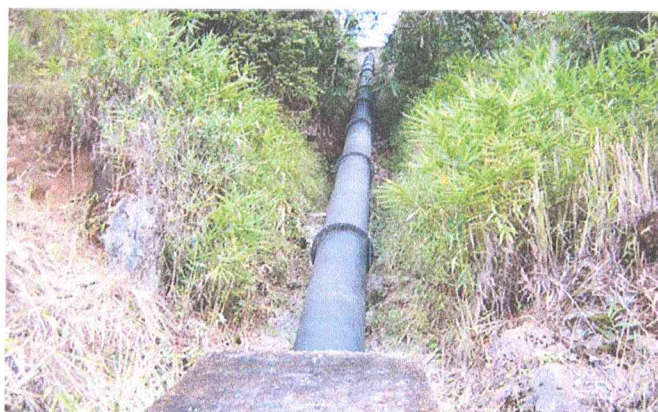
รูปที่ 3.6 ท่อส่งน้ำหรือท่อชักน้ำ [13]
