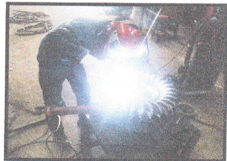
ชิ้นงานดำเนินการเชื่อม Tag Welding
