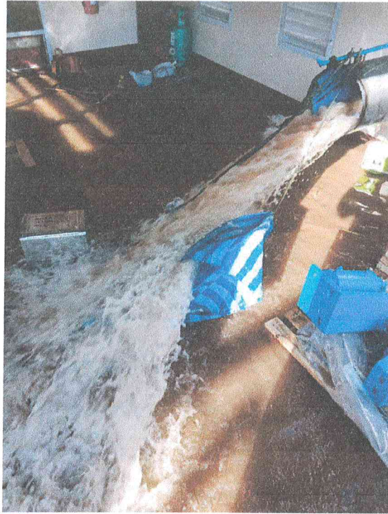
รูปที่ 4.15 การทำความสะอาดท่อชักน้ำ
