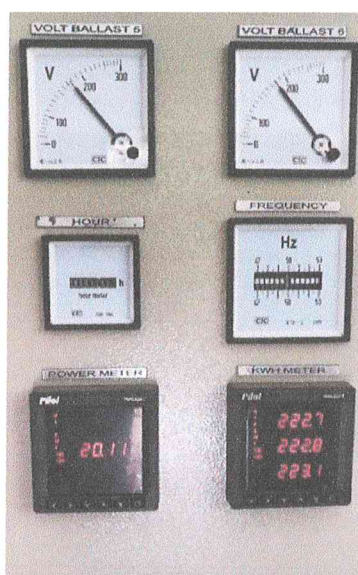
รูปที่ 5.4 หน้าจอแสดงผล Digital Power Meter ที่ตู้ควบคุม
