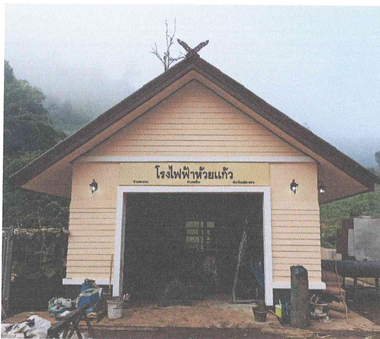
รูปที่ 3.7 อาคารโรงไฟฟ้า [13]
