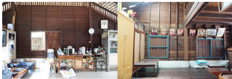
รูปที่ 5.1 ผนังไม้ตีซ็อนเกร็ดและหน้าต่าง
