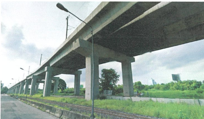
ทิศใต้-เส้นทางรถไฟฟ้าแอร์พอร์ตลิงค์
