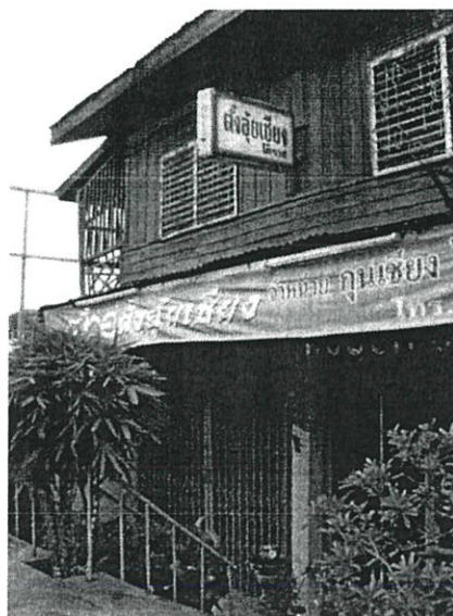
รูปที่ 5.32 แสดงภาพอาคารข้างเคียงที่ตั้งโครงการ
