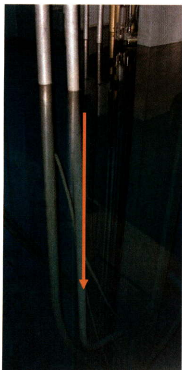
รูปที่ 2.28 ทิศทางของท่ออบรังสีด้วยลม มีทิศทางขนานไปกับแกนเครื่องปฏิกรณ์ และลงไปยังตำแหน่งของท่ออบรังสีที่ ตำแหน่ง G22 ของเครื่องปฏิกรณ์ ปปว.-1/1
