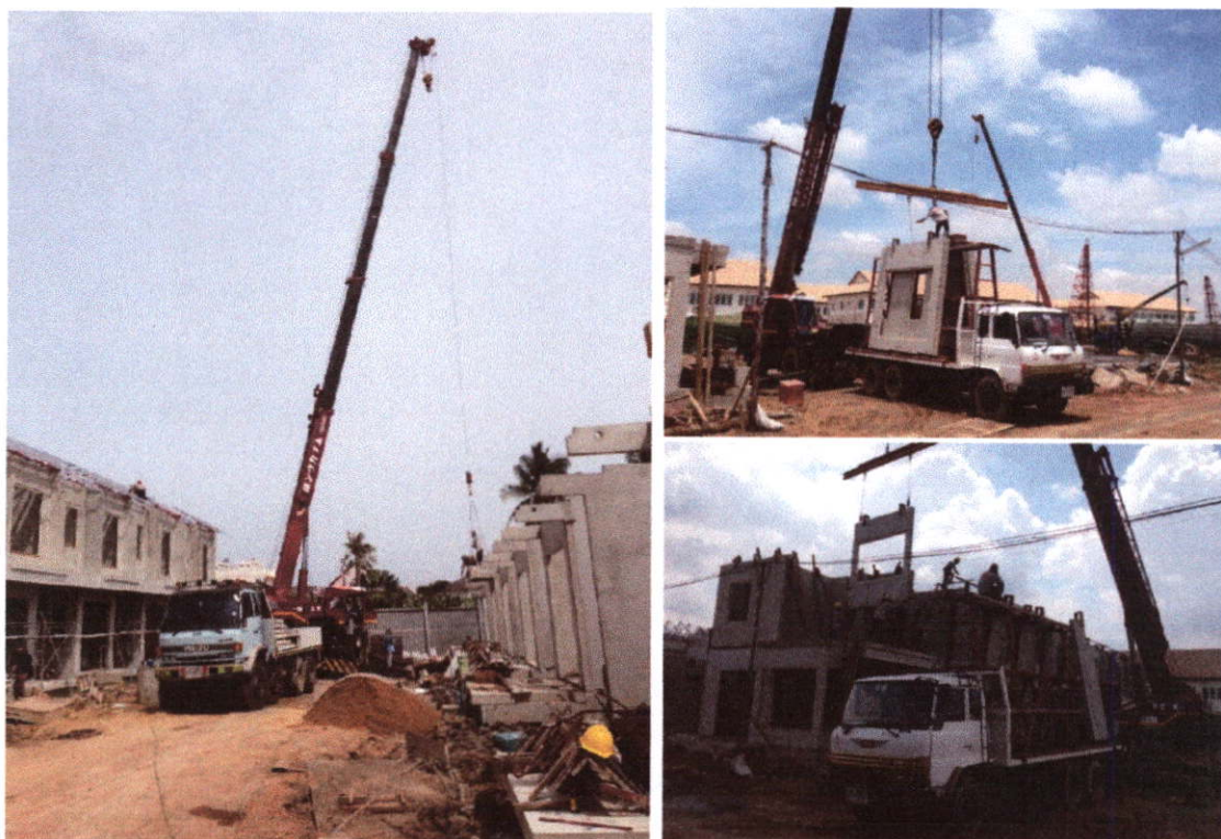
ภาพที่ 4.9 การติดตั้งชิ้นส่วนสำเร็จรูปของโครงการ A (ที่มา: ผู้วิจัย)
