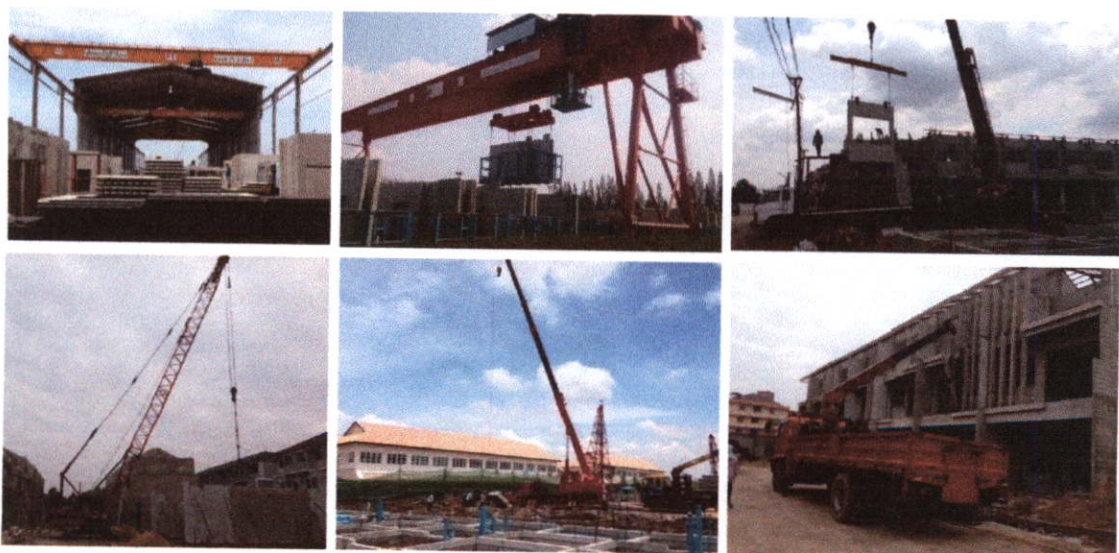
ภาพที่ 6.1 ประเภทของเครนที่พบในกระบวนการก่อสร้างบ้านพักอาศัยระบบชั้นส่วนสำเร็จรูป
