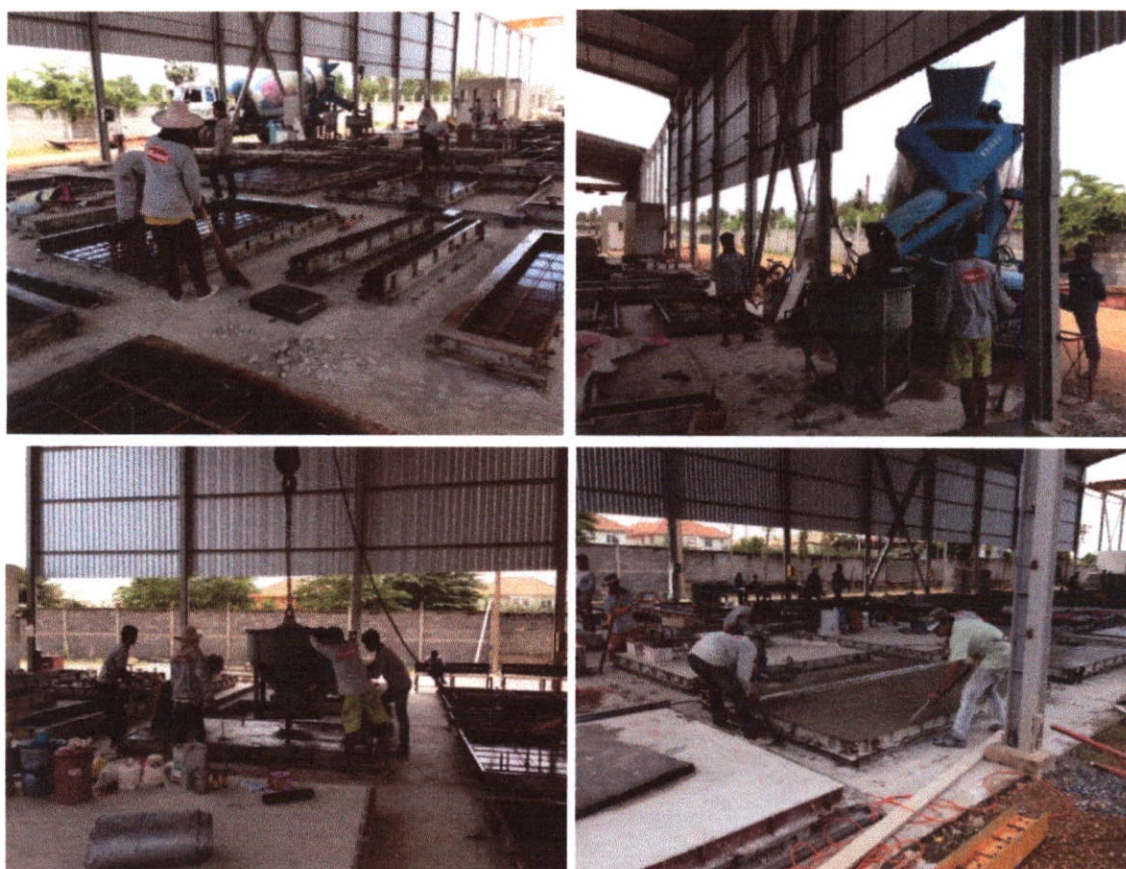
ภาพที่ 4.7 ขั้นตอนการผลิตแผ่นคอนกรีตชิ้นส่วนสำเร็จรูป (ที่มา: ผู้วิจัย)
