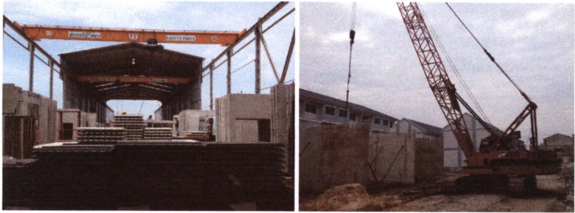
ภาพที่ 1.3 เครื่องที่ใช้ในการก่อสร้างบ้านพักอาศัยด้วยระบบชิ้นส่วนสำเร็จรูป
