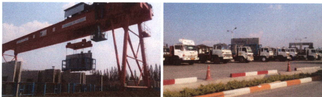
ภาพที่ 4.30 การขนส่งชิ้นส่วนสำเร็จรูปของโครงการ C
