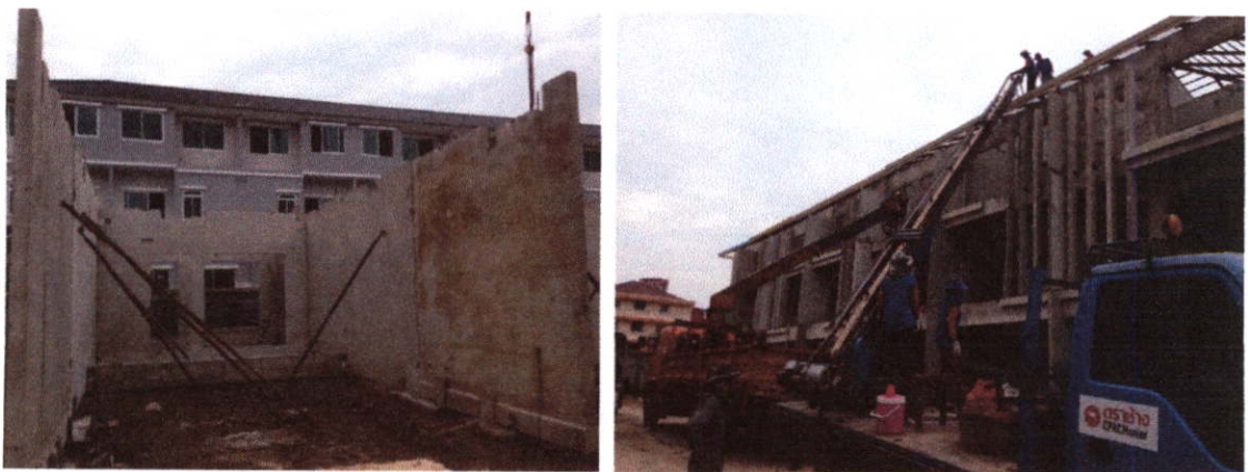
ภาพที่ 4.19 การติดตั้งชิ้นส่วนสำเร็จรูปของโครงการ B (ที่มา: ผู้วิจัย)
