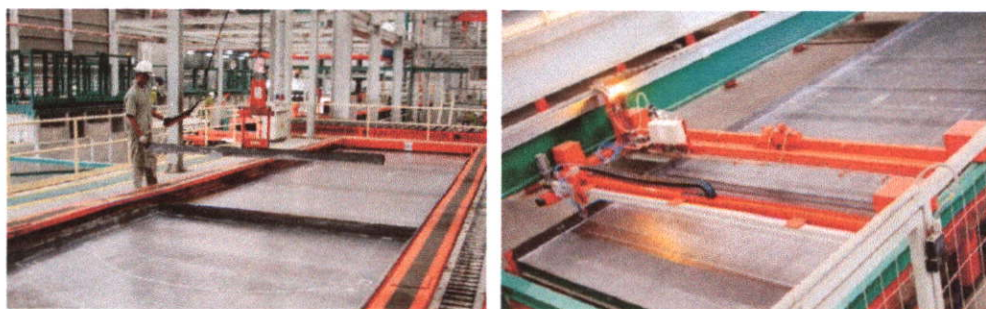
ภาพที่ 4.25 การเตรียมโต๊ะและวัสดุเพื่อผลิตชิ้นส่วนสำเร็จรูปของโครงการ C
