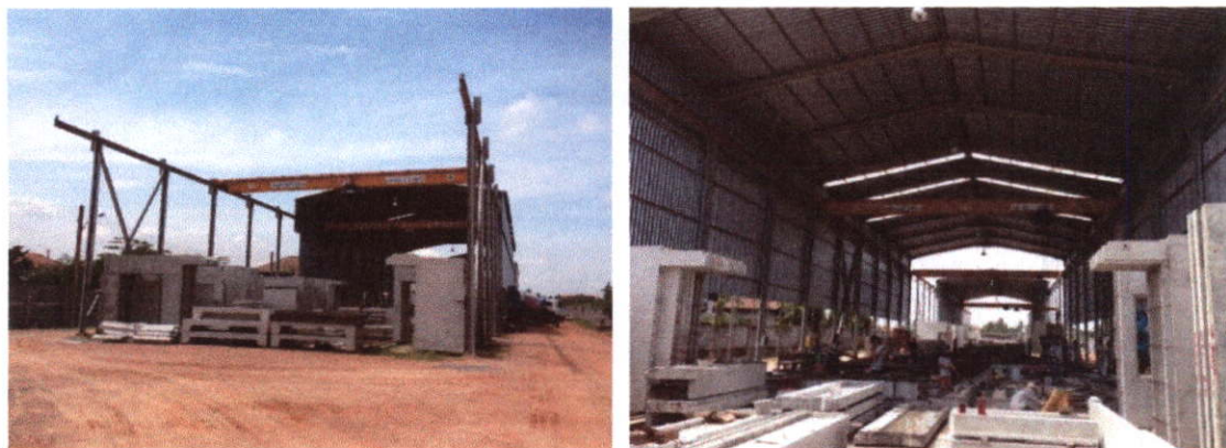
ภาพที่ 4.6 สภาพโรงงานผลิตแผ่นชิ้นส่วนคอนกรีตสำเร็จรูปของบริษัท A (ที่มา: ผู้วิจัย)
