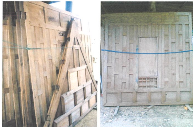
ภาพที่ 2.4 ภาพชิ้นส่วนถอดประกอบของบ้านเรือนไทย
