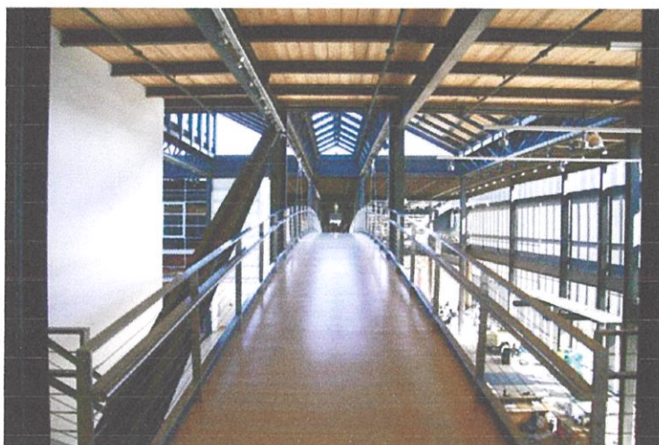
รูปที่ 3.31 สะพานเหล็กแขวนเชื่อมอาคารด้านหน้าและด้านหลัง
