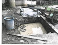
1. ขุดหลุมฝังเข็มเหล็กไว้กับ สลักเหล็กในลักษณะที่เห็น
