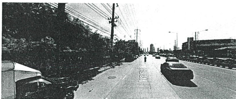
ภาพที่ 5.18 แสดงภาพถ่ายด้านหน้าโครงการ ตัดถนนพระราม3
