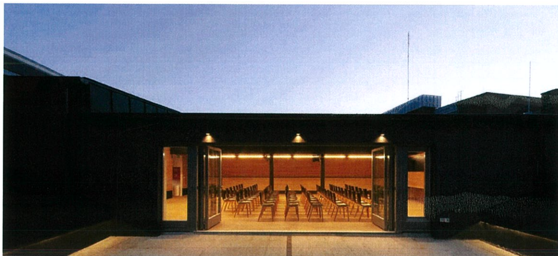
ภาพที่ 5. 47 ส่วนห้องประชุมที่เชื่อมต่อกันลานกิจกรรมกลางแจ้งที่อยู่ชั้นดาดฟ้า
