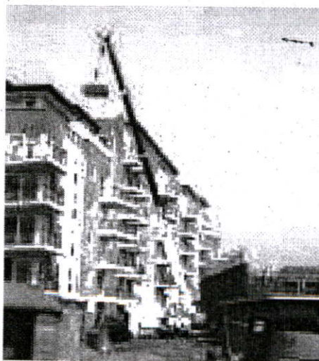
รูปที่ 2.30 แสดงการใช้รถเครนขนาดใหญ่เพื่อนำต้นไม้ไว้บนอาคาร
