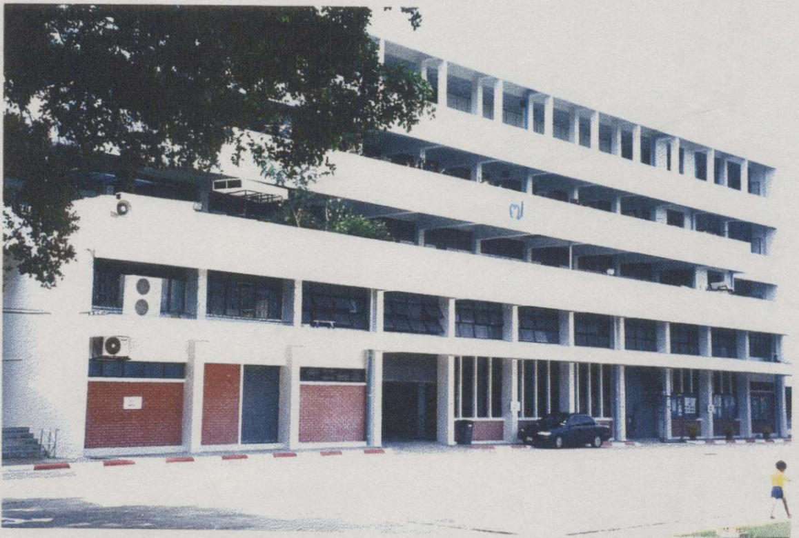
ภาพที่ 2.13 แสดงอาคารโรงฝึกงานช่างปูน ( โรงงานปูน )
