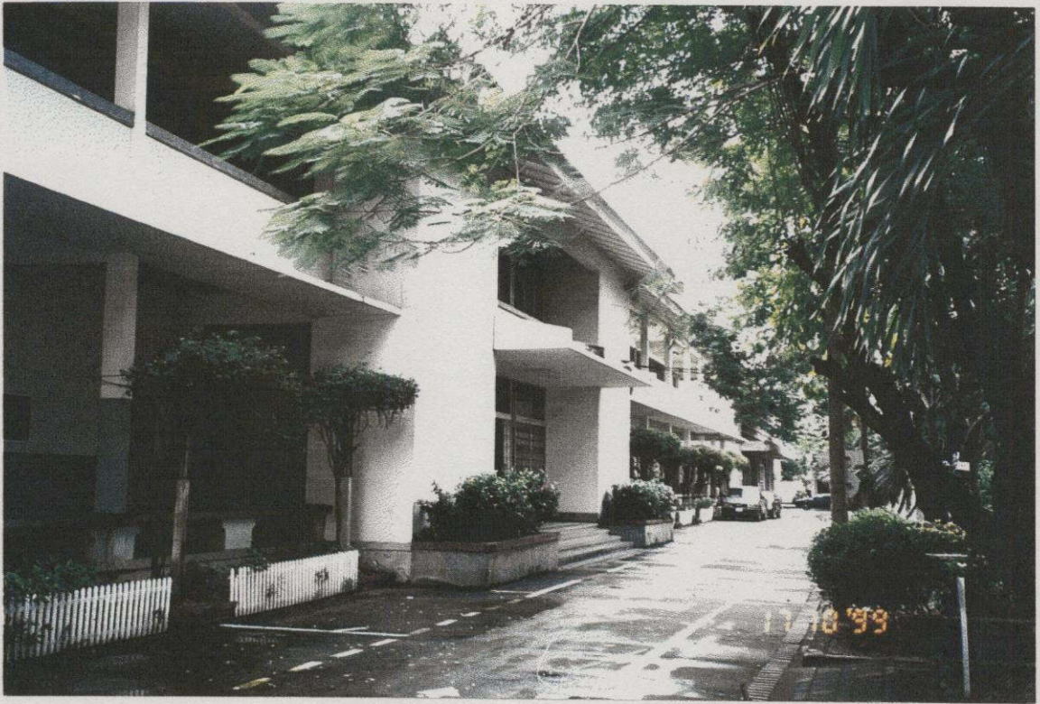
ภาพที่ 2.6 แสดงอาคาร กศส. ( ศูนย์คอมพิวเตอร์ , ห้องสมุด , ห้องเทคโนโลยีทางการศึกษา )
