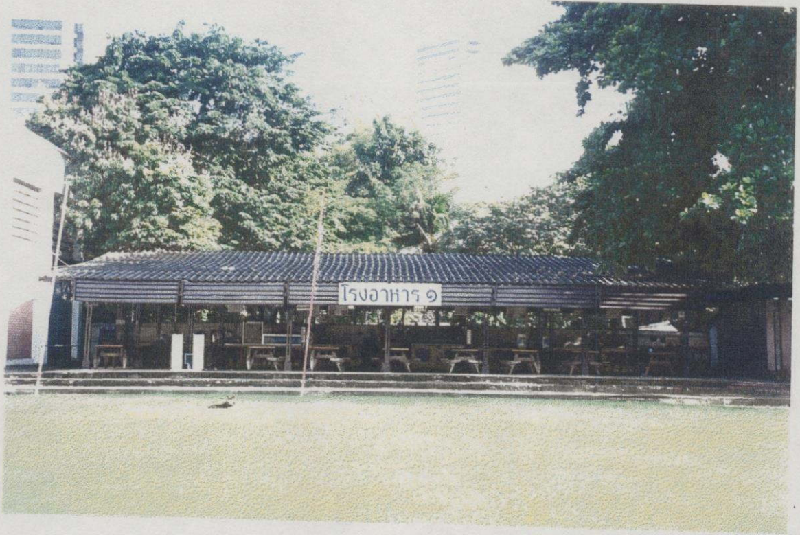
ภาพที่ 2.16 แสดงอาคารโรงอาหาร 1 (อาคารชั่วคราว)
