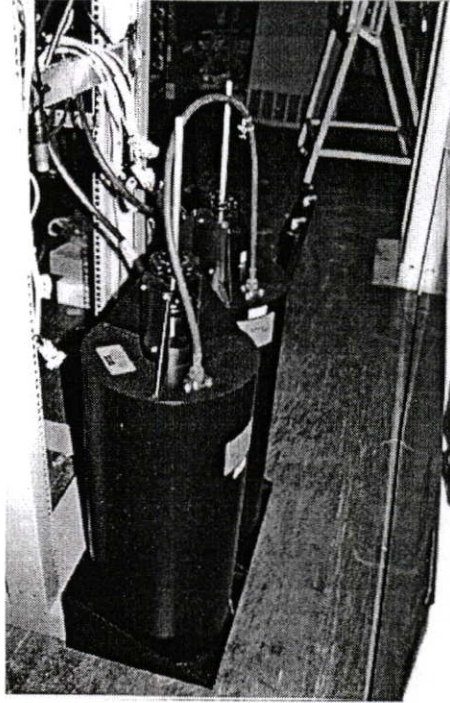
(d) Two Bandpass Cavity ( DECIBELL DB4060-WOC-C )
