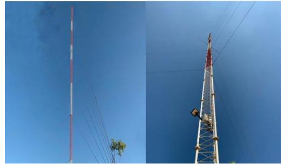
รูปที่ 2 ลักษณะการติดตั้งอุปกรณ์ตรวจวัดความเร็วลมบนเสาที่ความสูง 2 ระดับ
