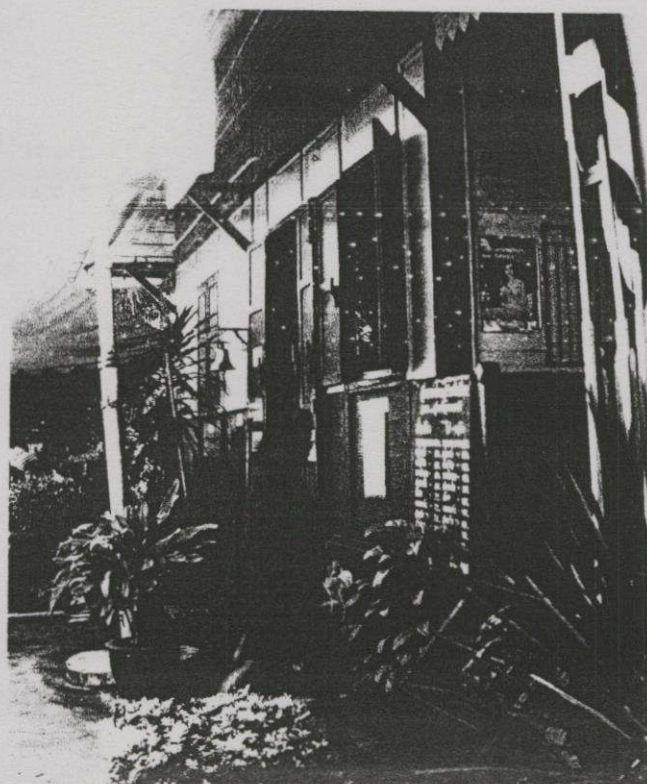
ภาพที่ 4.17 แสดงบริเวณทางเข้า บริเวณซื้อตั๋วและ โถงพักคอยภายในสถานีลาดกระบัง
