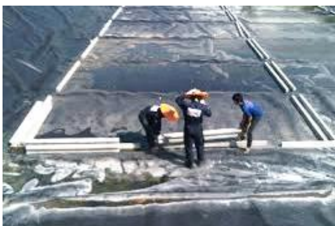
ภาพที่ 2.7 การปูผ้าโพลีเอทิลีน (พีอี) ในบ่อเลี้ยงกุ้ง
