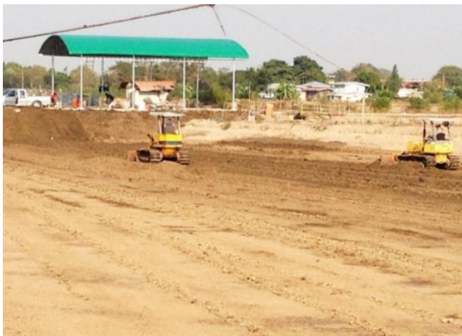
ภาคผนวก ค 4 การใช้รถแทรกเตอร์ดันดินพื้นบ่อ
