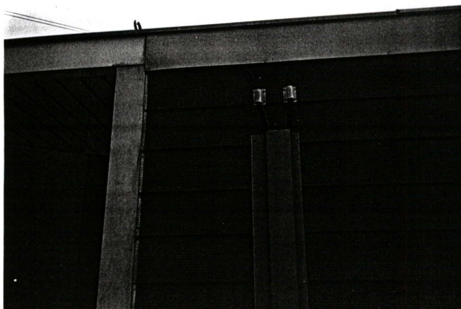
รูปที่ 2.155 การเดินสายไฟฟ้าภายนอกที่ผนัง
