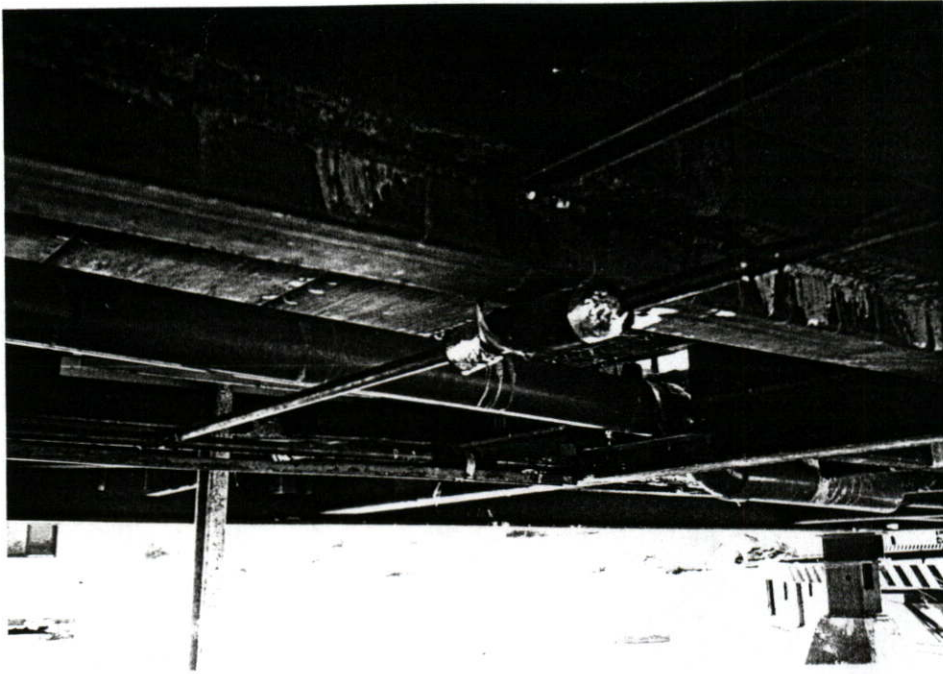
รูปที่ 2.187 ท่อน้ำร้อนใต้พื้น ใช้ท่อทองแดงหุ้มฉนวนกันความร้อน
