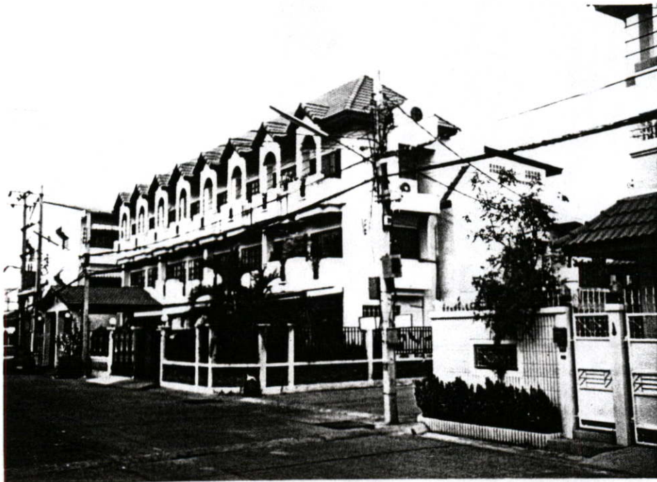
รูปที่ 2.101 ตัวอย่างโครงการอาคารสำนักงานและที่พักอาศัย โครงการเกษราโฮมออฟฟิศ
