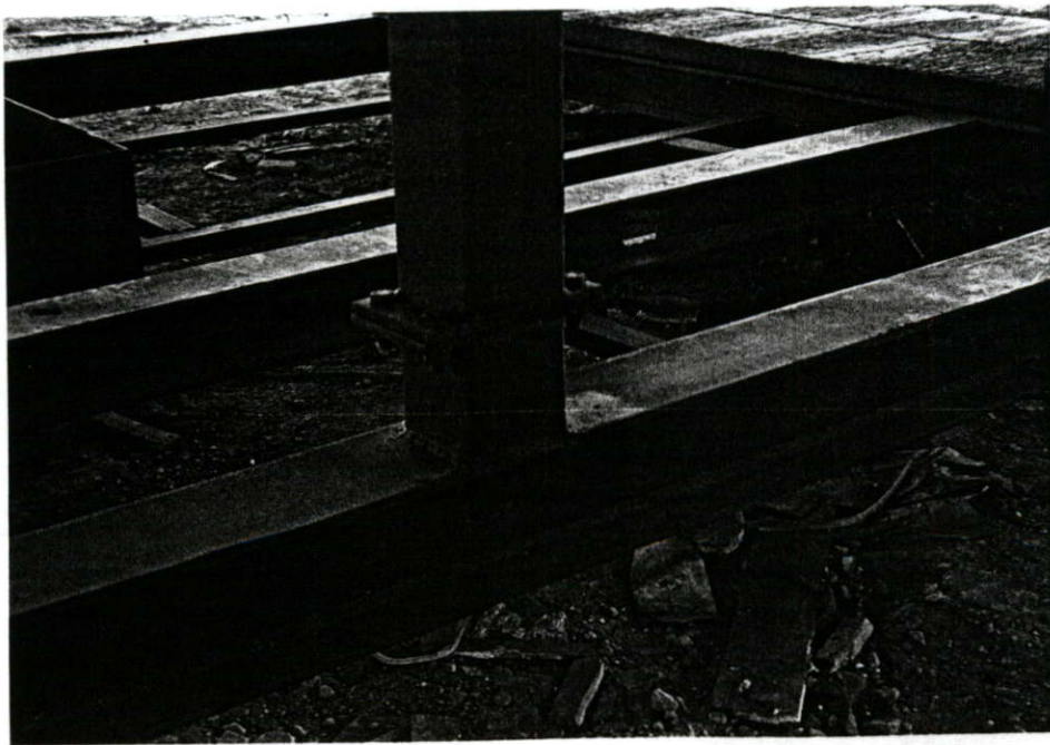
รูปที่ 2.194 รอยต่อเสาเหล็กตอนล่าง และคานรับแผ่นพื้นคอนกรีต
