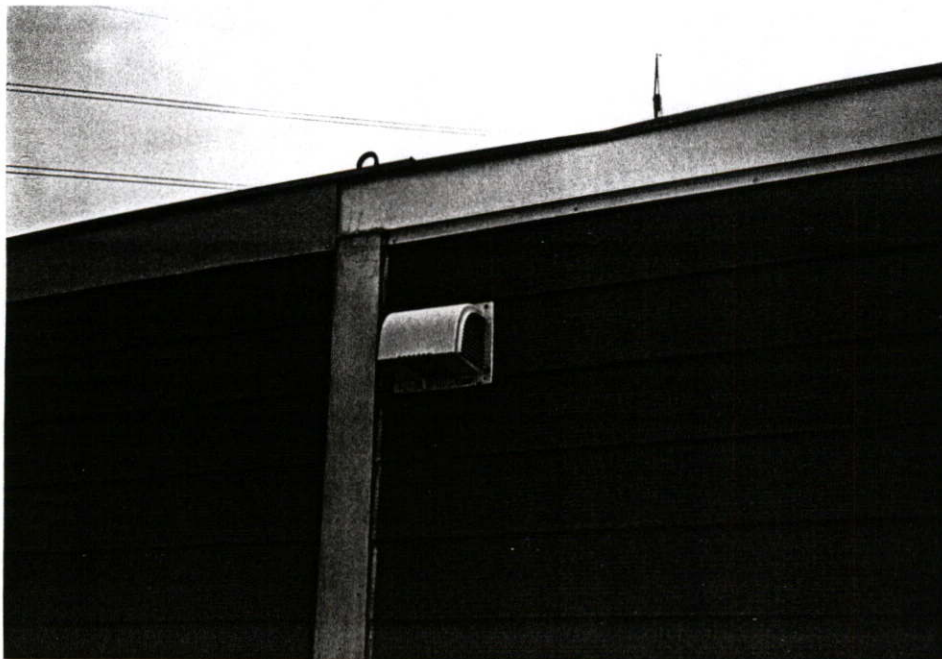
รูปที่ 2.153 ช่องระบายควันจากห้องครัว
