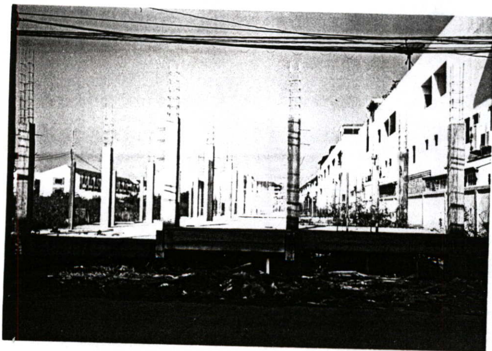
รูปที่ 2.92 การก่อสร้างอาคารสำนักงานและที่พักอาศัย
