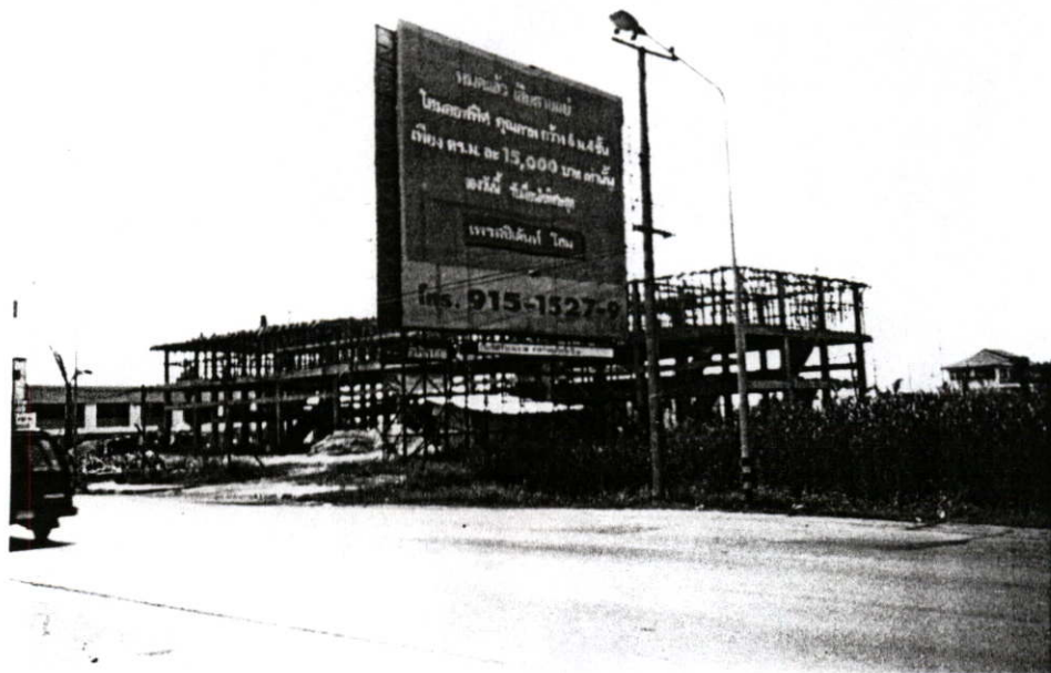
รูปที่ 2.93 การก่อสร้างอาคารสำนักงานและที่พักอาศัย
