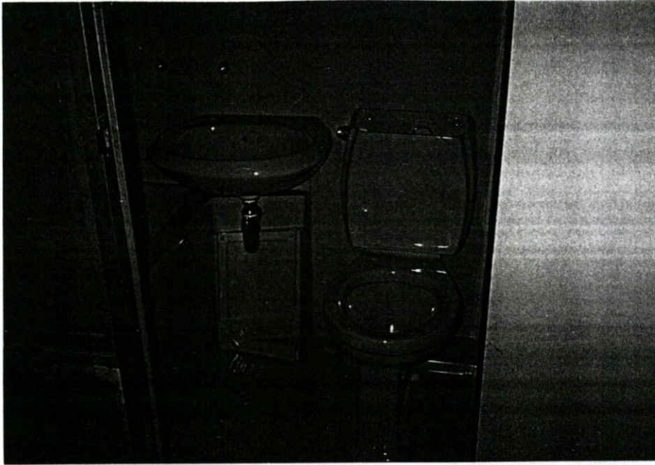
รูปที่ 2.176 ภายในห้องน้ำสำเร็จรูปติดตั้งสุขภัณฑ์เรียบร้อยจากโรงงาน
