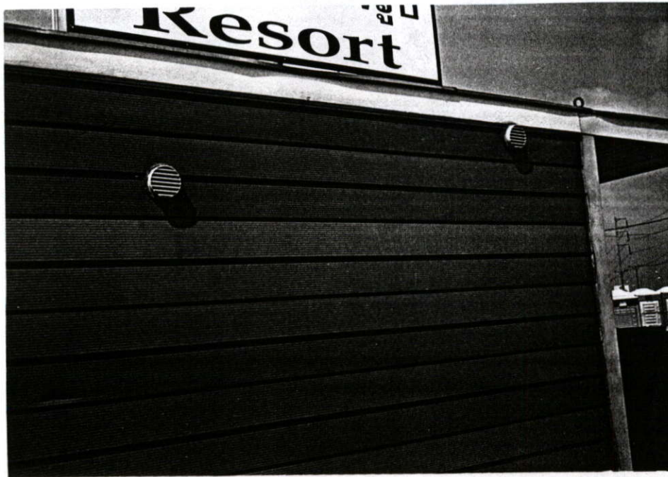
รูปที่ 2.152 ช่องระบายอากาศจากภายในสู่ภายนอก
