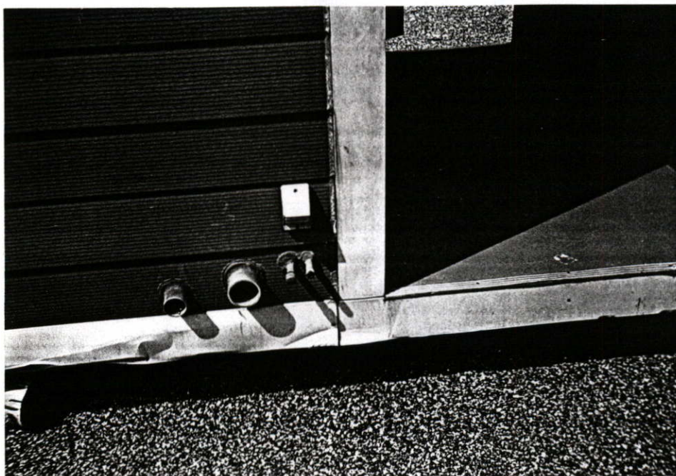
รูปที่ 2.154 ท่อน้ำดีและท่อน้ำเสียจากภายนอก
