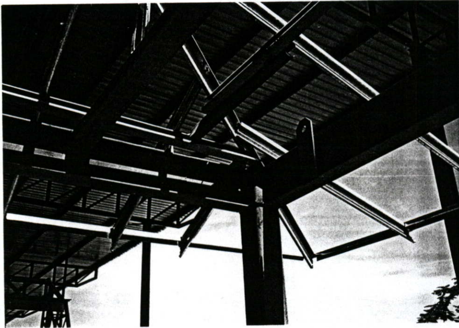
รูปที่ 2.191 รอยต่อเสาเหล็กคอนกรีตบน หูหัวสำหรับขนส่งและโครงหลังคา
