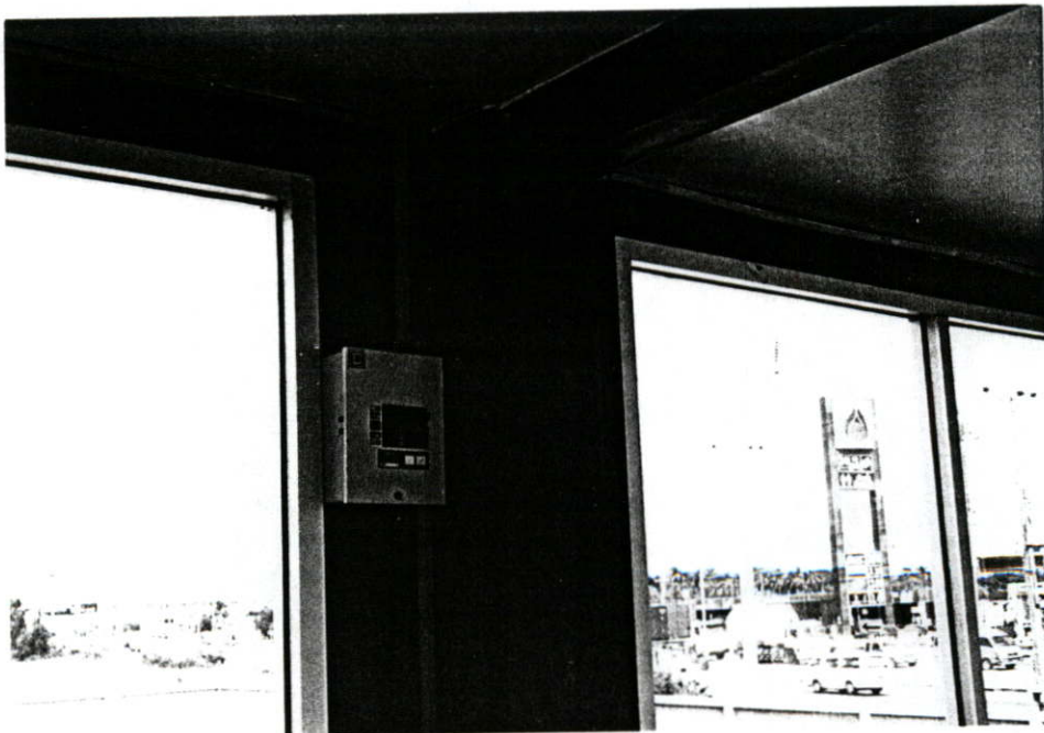
รูปที่ 2.163 รอยต่อเสา คาน ผนังที่เพดานและตำแหน่งแผงควบคุมสวิทซ์ไฟของสำนักงาน สำเร็จรูปที่ติดตั้งอยู่ที่ผนังคอนกรีต
