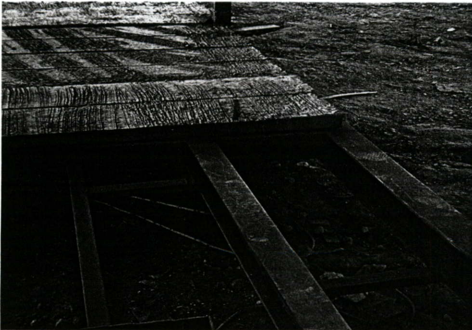
รูปที่ 2.196 การวางแผ่นพื้นคอนกรีตบนคานเหล็ก
