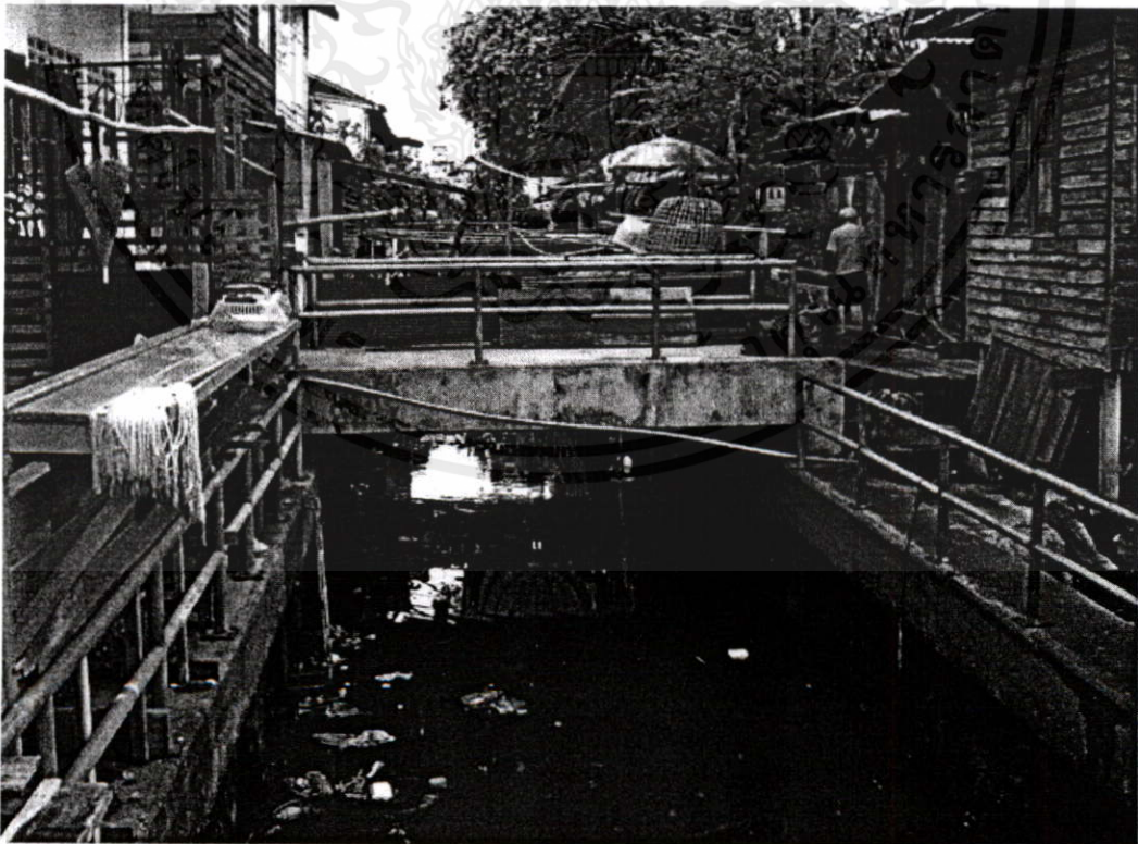
ภาพที่ 4.19 แสดงการก่อสร้างอาคารลู่ล้ำคูสาธารณะ ทำให้การพัฒนาเส้นทางสัญจรใช้ประโยชน์ได้ไม่เต็มที่
