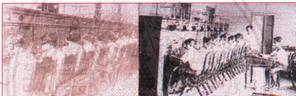
ภาพที่ 1 ชุมสายโทรศัพท์ระบบไฟกลางที่ใช้พนักงานต่อ
