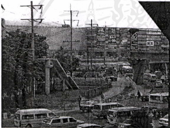
รูปที่ 4.73 ภาพปัจจุบันขณะกำลังก่อสร้างเส้นทางสีน้ำเงิน รถยนต์จากถนนรังสิต-นครนายก
