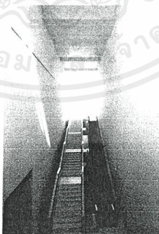
รูปที่ 3.27 แสดงโถงบันไดภายในอาคาร
