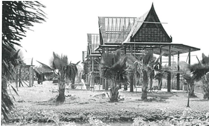
ภาพที่ 2.9 ส่วนของบ้านพักทรงไทยประยุกต์ที่กำลังสร้าง (เข้าถึงเมื่อวันที่ 6 เดือนพฤศจิกายน 2555 )
