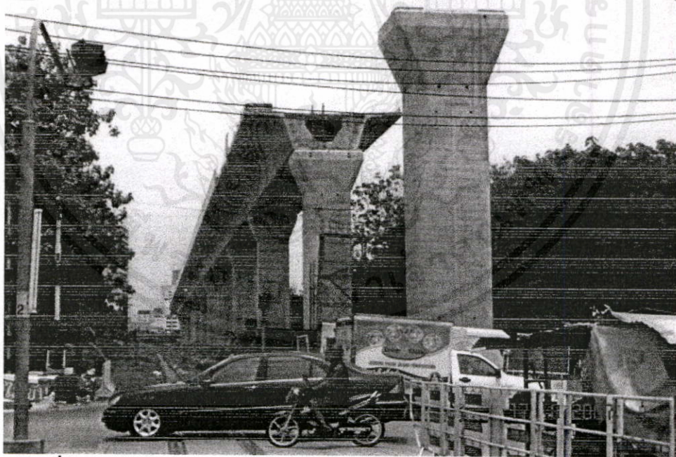
รูปที่ ผ.ช.16 แสดงบริเวณก่อสร้าง โครงการฯ บริเวณ ชุมชนเพชรพระราม (รูป 2)
