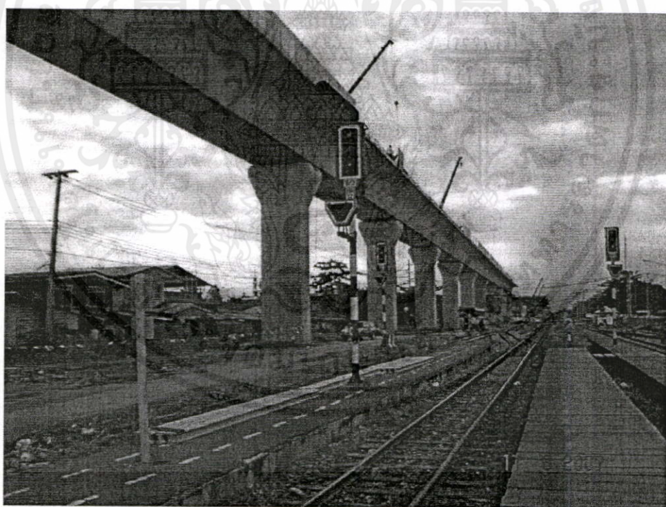
รูปที่ ผ.ช.24 แสดงบริเวณก่อสร้างโครงการฯ บริเวณ สถานีรถไฟหัวหมาก (รูป 2)
