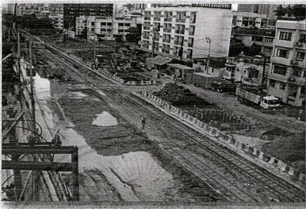
รูปที่ ผ.ช.3 แสดงบริเวณก่อสร้างโครงการฯ บริเวณ พญาไท (รูป 1)
