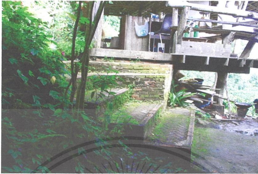
ภาพที่ 5.30 การเชื่อมต่ออาคาร โดยใช้วัสดุธรรมชาติ
