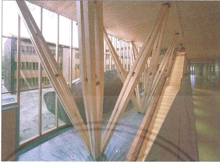
ภาพที่ 5.33 แสดง โครงสร้างเสาของโครงการ
