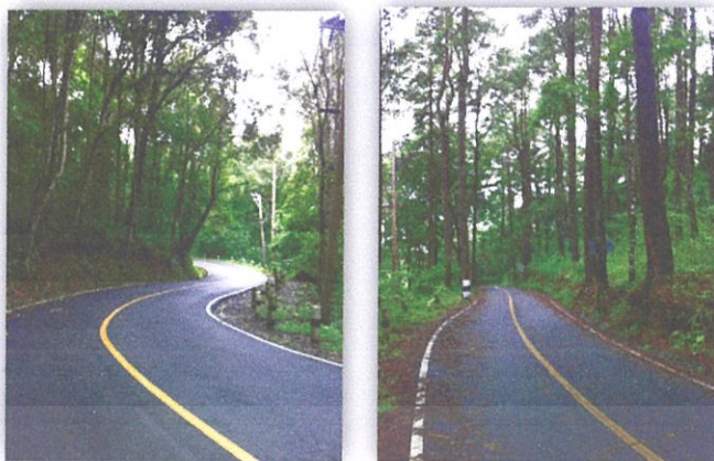
ภาพที่ 4.11(B) ถนนเข้าโครงการ กว้าง 6 เมตร
