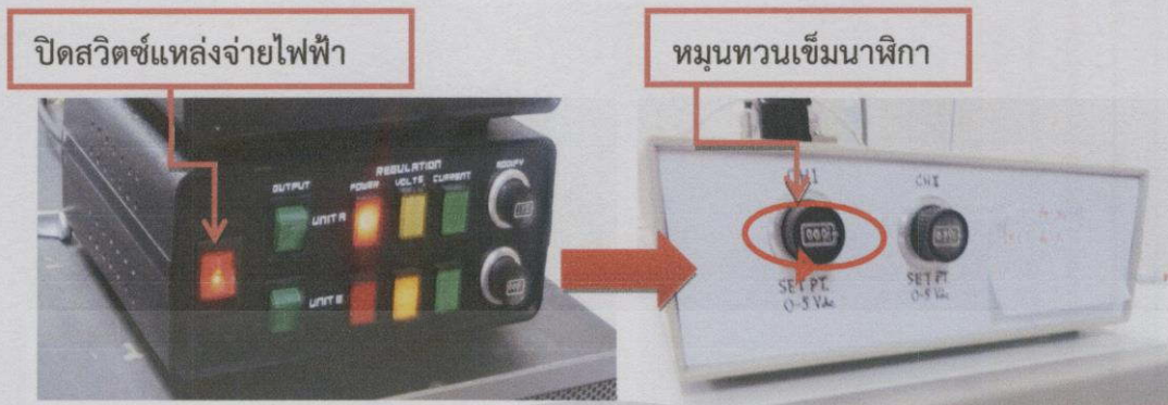
รูปที่ 3.16 ปิดสวิตซ์แหล่งจ่ายไฟฟ้าและวาล์วควบคุมแรงดันแก๊สอาร์กอน
