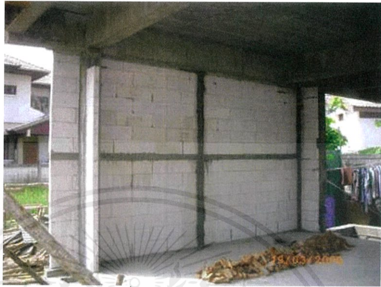
ภาพที่ 7.1 แสดงผนังก่ออิฐฉาบปูน
