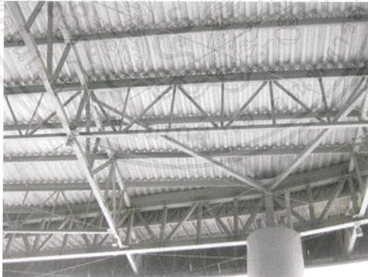
ภาพที่ 7.3 แสดงหลังคาโครงสร้างเหล็กWide Span
