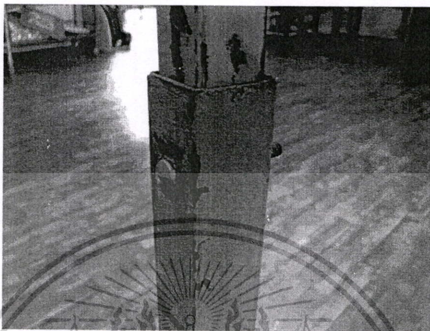
ภาพที่ 2.6 ภาพแสดงลักษณะของกล่องเหล็กในการปรับสูง-ต่ำของขาโต๊ะ
