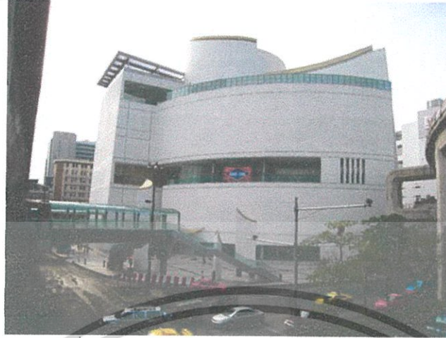
ภาพที่ 5 ด้านนอกอาคารจากมุมมองบน Skywalk
