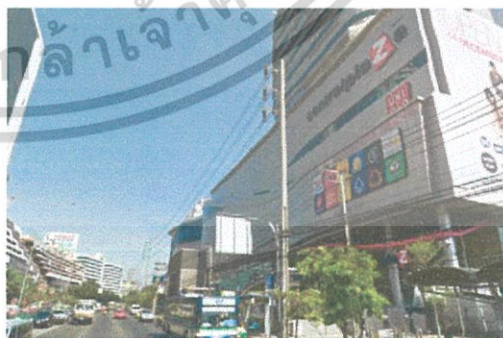
ภาพที่ 2.4 ด้านซ้ายพื้นที่ (ทิศตะวันตก)
