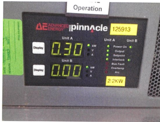
รูปที่ 7 จอแสดงเอาต์พุตของแรงดัน กระแส และกำลังไฟฟ้าขณะสปีดเตอร์
