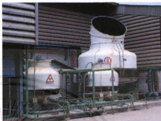
ภาพที่ ลักษณะของระบบปรับอากาศส่วนกลาง (ออนไลน์) 2549
