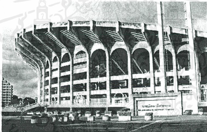
รูปที่ 6.10 แสดงโครงสร้าง RIGID FRAME กับงานสนามกีฬาราชมิ่งคลากีฬาสถาน
