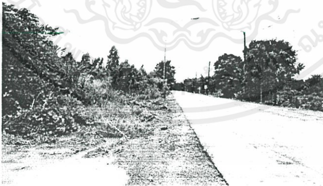
รูปที่ 6. 18 แสดงพื้นที่ถนน หน้าโครงการ
