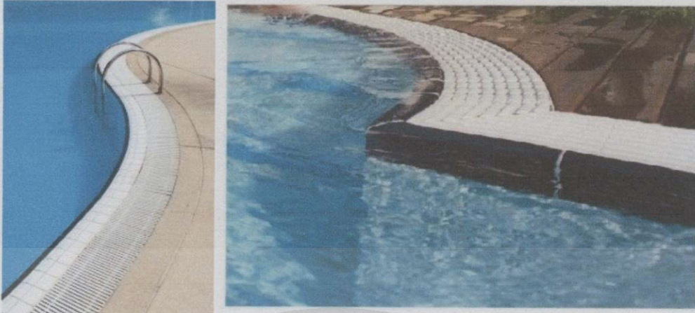
รูปที่ 7.7 แสดงระบบหมุนเวียนน้ำแบบโอเวอร์โฟลว
