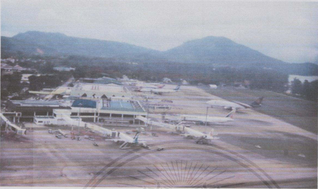
ภาพที่ 3-10 แสดงอาคารการวางอาคารแบบ Linear Terminal ของท่าอากาศยานภูเก็ต ที่มา : http://www.skyscrapercity.com/showthread.php?p=68998513
