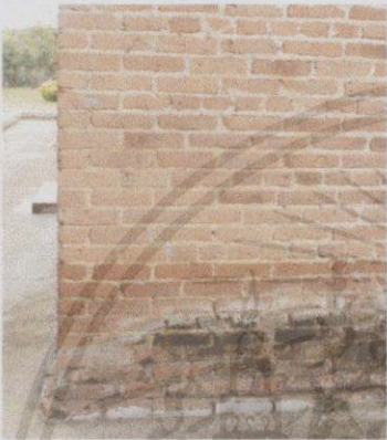
ภาพที่ 2.12 แสดงวิธีการก่ออิฐแบบ English garden wall bond
