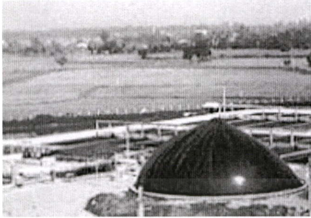
รูปที่ 2.8 บ่อหมักแบบ H-UASB
