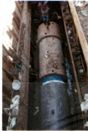
รูปที่ 2.14 การวางท่อต้นลงในตำแหน่งเดียวกันกับรางเหล็ก
