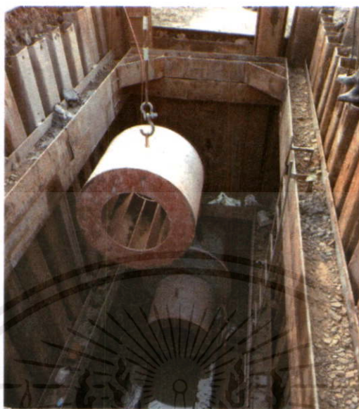
รูปที่ 4.11 การประกอบท่อตันเข้ากับหัวน้ำ
