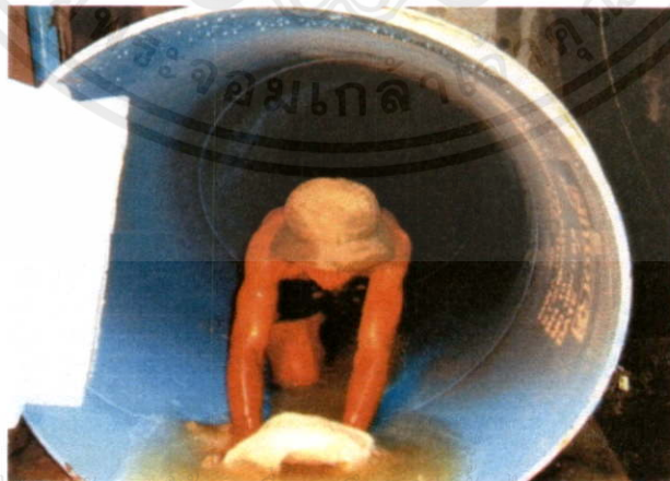
เอกสารนี้เป็นเอกสารที่สงวนไว้สำหรับบริการใช้งานเพื่อการศึกษเท่านั้น ไม่อนุญาตให้นำไปใช้ประโยชน์ด้านการค้า ไม่ว่ากรณีใดๆทั้งสิ้น อีกทั้งห้ามมิให้ทำซ้ำ แจกจ่าย หรือเผยแพร่เอกสารทุกครั้งที่มีการนำไปใช้ รูปที่ 4.23 การล้างทำความสะอาดภายในท่อ
