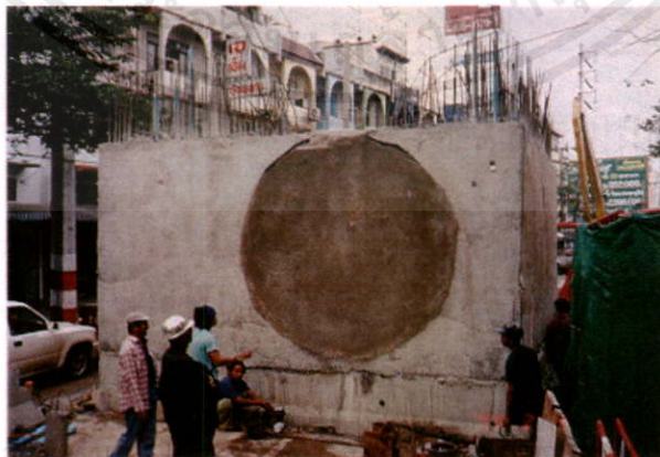
รูปที่ 2.4 “Soft Eye” จุดซึ่งหัวเจาะจะต้องเจาะผ่านออกจากบ่อตัน หรือเจาะผ่านเข้าไปในบ่อรับ
