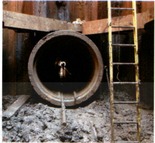
รูปที่ 5.3 พื้นคอนกรีตคูดักันหลุมเสียหายจากการอูบวม (Heave)
