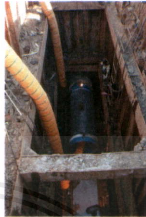
รูปที่ 2.14 การวางท่อต้นลงในตำแหน่งเดียวกันกับรางเหล็ก
