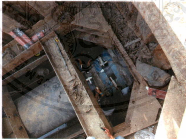
รูปที่ 4.16 การติดฟิล์มที่ทำการ X-Ray
