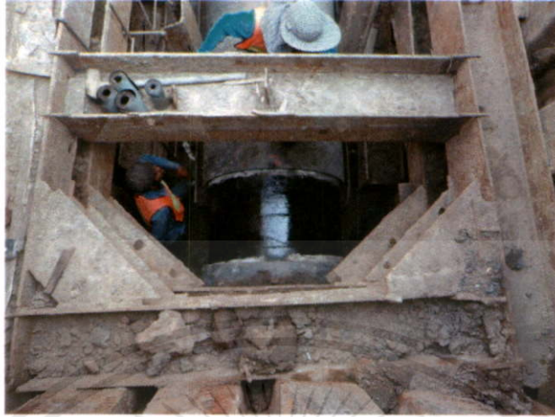
รูปที่ 4.20 การพันโมโนเทป (บริเวณแนวรอยเชื่อม)
