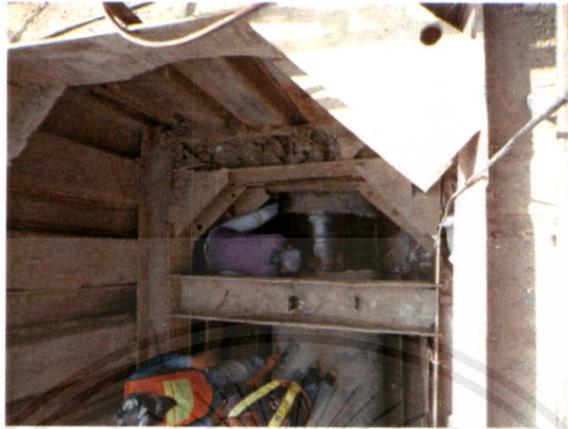
รูปที่ 4.4 บ่อสำหรับเชื่อมต่อ
