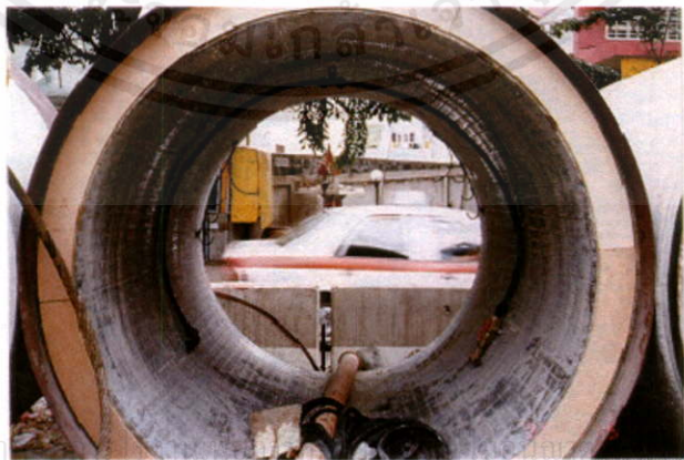
รูปที่ 2.6 ท่อตัน (Jacking Pipe)
