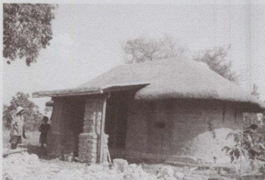
ภาพที่ 7.3 แสดงการก่อสร้างอาคารจากดิน 2
