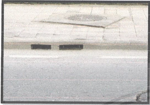
รูปที่ 4.41 จุดที่ควรแก้ไขที่ 41 ทางระบายน้ำมีการชำรุดเสียหายรวมทั้ง ขอบฟุตบาทมีการชำรุดเสียหาย
