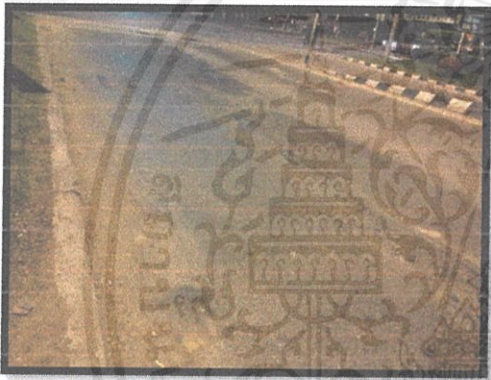
รูปที่ 4.50 จุดที่ควรแก้ไขที่ 50 พื้นผิวถนนเกิดการชำรุด เป็นพื้นที่ต่าง ระดับ
