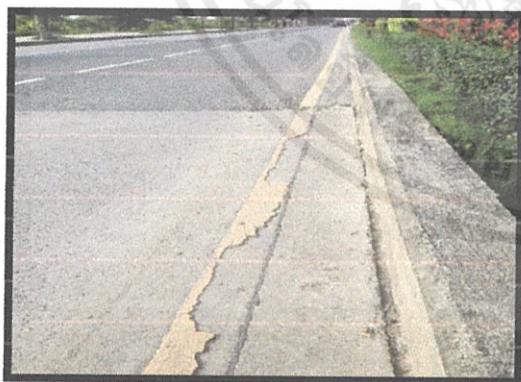
รูปที่ 4.4 จุดที่ควรแก้ไขที่ 4 เส้นขอบทางมีการชำรุดไม่อยู่ในสภาพ พร้อมใช้งาน
