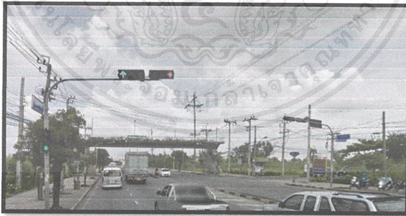
รูปที่ 3.2 สภาพทางแยกวัดสุทธาโภชน์ที่ทำการตรวจสอบความปลอดภัย
