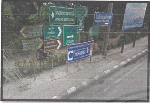
รูปที่ 4.19 จุดที่ควรแก้ไขที่ 19 การติดตั้งป้ายต่ำกว่าระดับมาตรฐานและมีการรुकล้ำพื้นที่คนเดินเท้า
