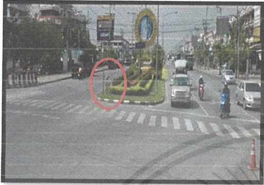
รูปที่ 4.16 จุดที่ควรแก้ไขที่ 16 ป้ายจราจรไม่เป็นที่สังเกตเห็นได้ง่ายและมี สภาพชำรุด
