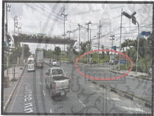
รูปที่ 4.3 จุดที่ควรแก้ไขที่ 3 ระยะการมองเห็นบริเวณทางแยกถูกบดบัง จากต้นไม้และป้ายโฆษณา
