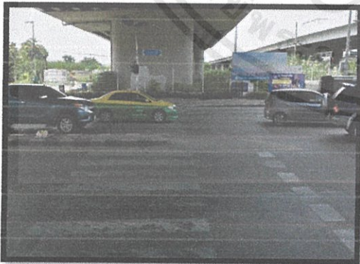
รูปที่ 4.56 จุดที่ควรแก้ไขที่ 56 บริเวณทางม้าลายมีเกาะกลางถนนที่ไม่มี ทางลาด ทำให้คนพิการไม่สามารถข้ามถนนได้
