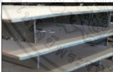
รูปที่ 3 เหล็กแห่งเสริมความแข็งแรงของแผ่นเหล็กกล้าเกรด SS400
