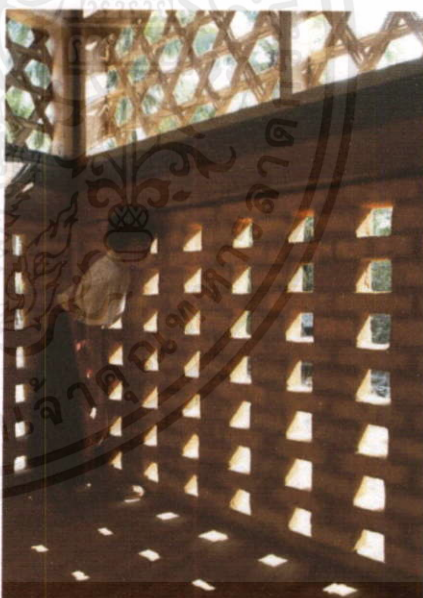
ภาพที่ 3.130 การก่ออิฐเป็นช่องแสง
