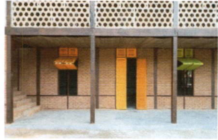
ภาพที่ 3.132 ทศนิยมภาพภายนอกอาคาร
