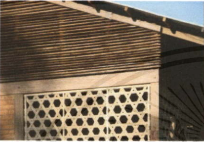
ภาพที่ 3.133 วัสดุในการก่อสร้างอาคาร
