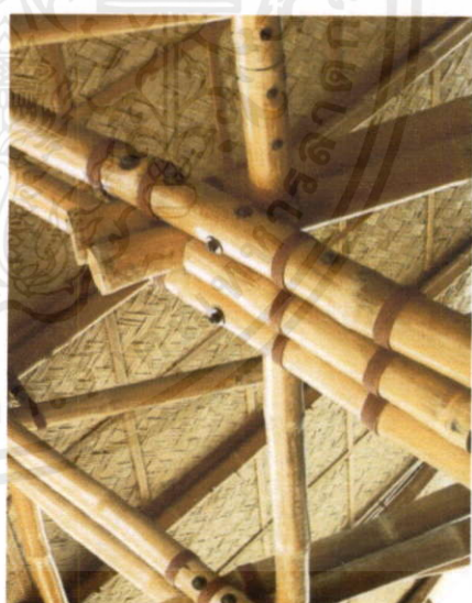
ภาพที่ 3.123 รอยต่อโครงสร้างหลังคา
