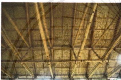
ภาพที่ 3.120 โครงสร้างหลังคา
