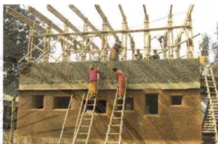
ภาพที่ 3.140 กระบวนการก่อสร้างอาคาร
