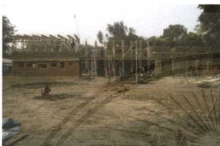
ภาพที่ 3.139 กระบวนการก่อสร้างอาคาร
