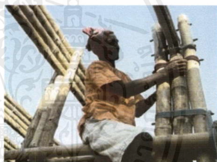
ภาพที่ 3.142 การประกอบโครงสร้างไม้ไผ่
